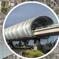
Estación Carlos Valdivinos
